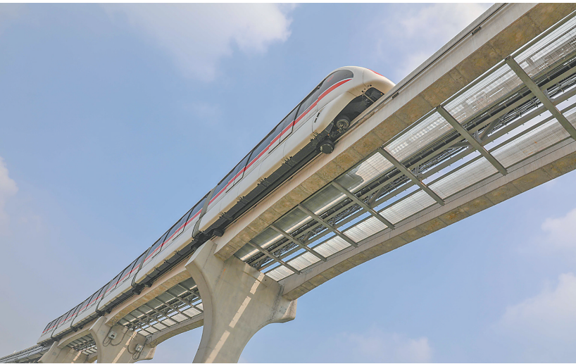
11月3日,芜湖市无人驾驶跨座式单轨列车在行驶中。 当日,安徽省芜湖市轨道交通1号线开通运营。该线路是一条无人驾驶跨座式单轨,全长约30公里,沿城市南北向铺设,设高架站25座,设计时速80公里。该线路开通运营后,将有效缓解交通拥堵状况,方便市民生活。 (新华社发)
