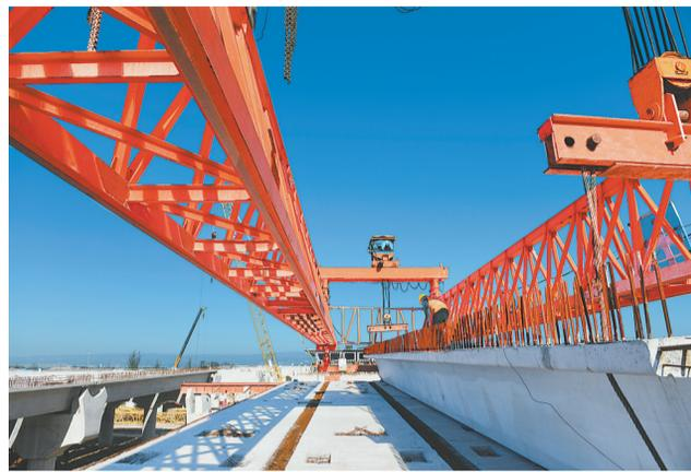
11月22日,市东海大道项目跨荷宝高速桥施工现场,施工队在作吊梁前准备。东海大道新建跨荷宝高速桥计划投资1.2亿元,全长共计540米。桥梁设计主桥采用单跨60米简支钢箱梁,两侧引桥采用30米简支转连续小箱梁,双幅桥布置,每幅宽25.75米。目前,该项目正在进行预制箱梁架设和钢箱梁拼装施工,计划年底完成钢箱梁的顶推施工,明年5月底实现全桥通车。
